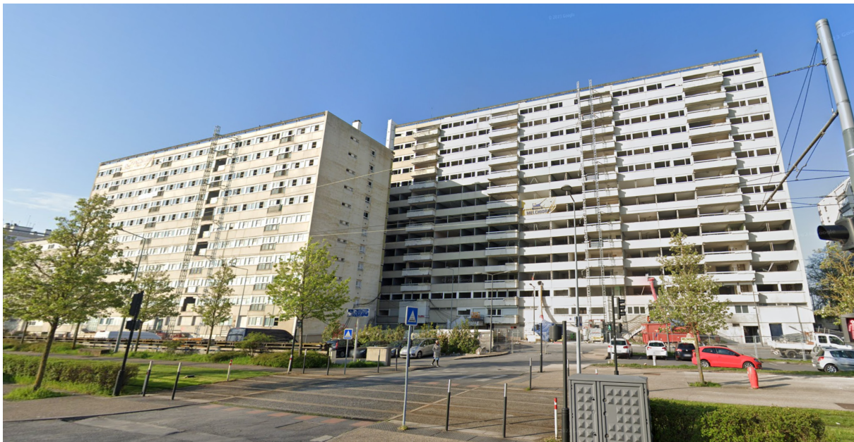
Figure 44 : Photo des immeubles concernés par le projet de désamiantage / démolition
