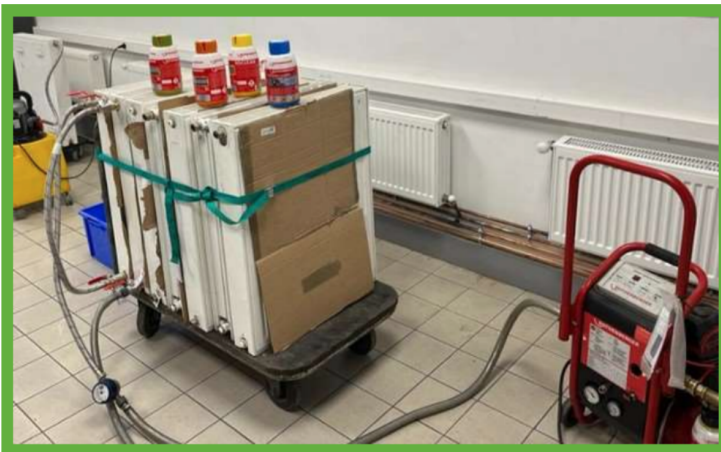
Figure 22 : Reconditionnement des radiateurs
